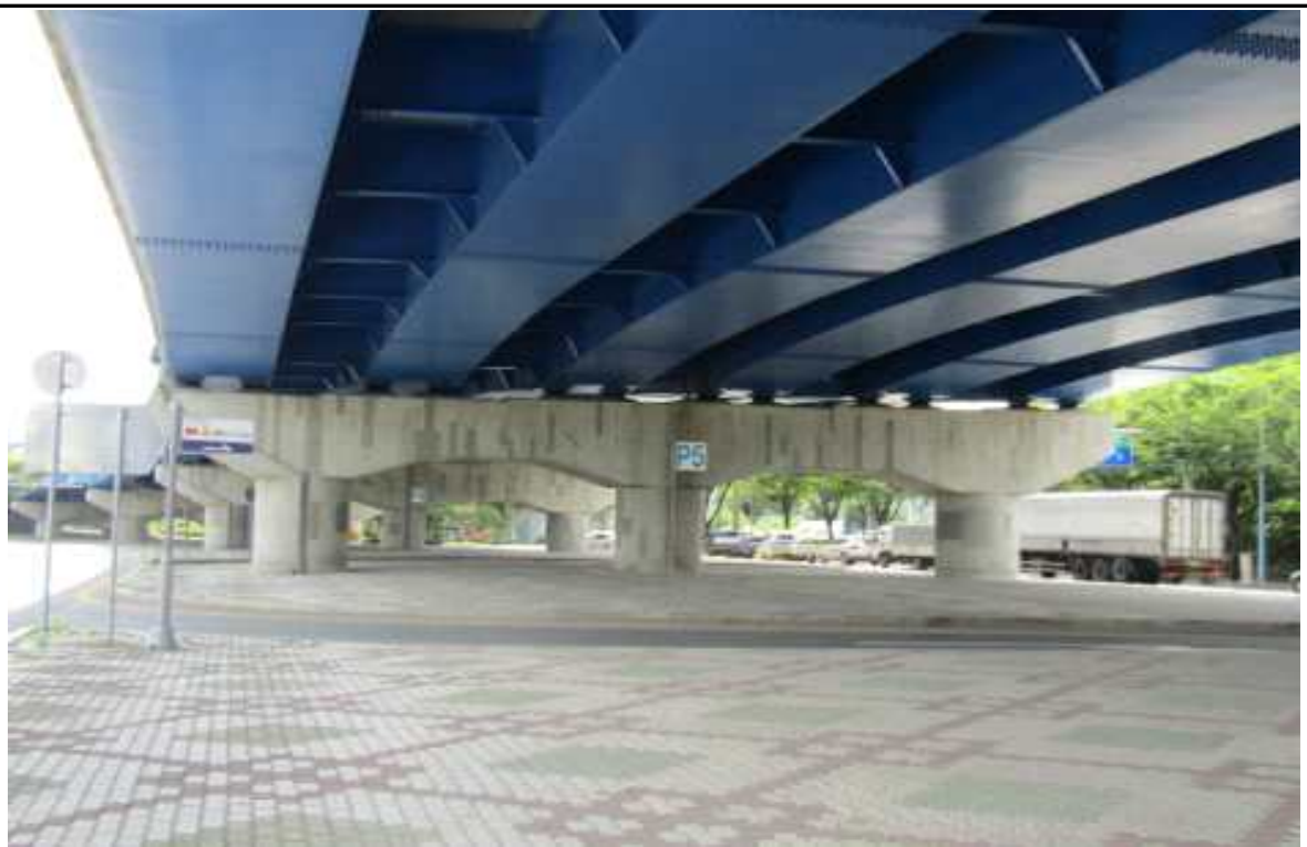
하부구조 전경 - 교각(P3)
