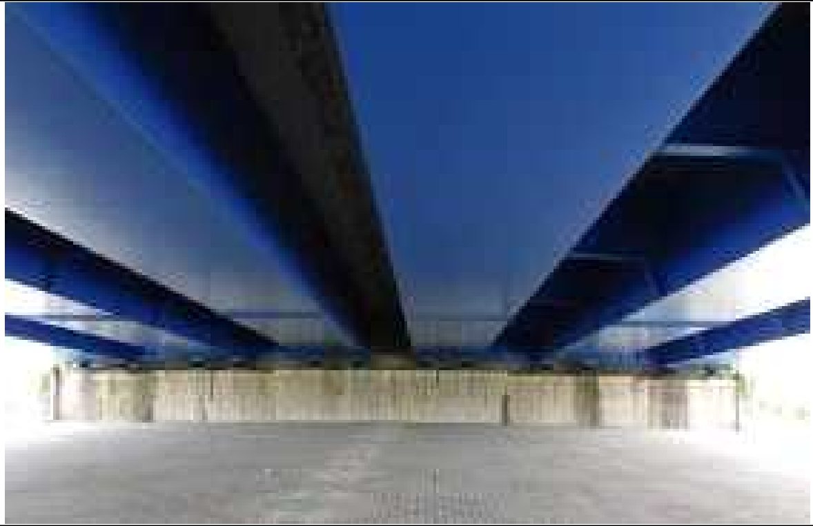
하부구조 전경 - 교대(A1)
