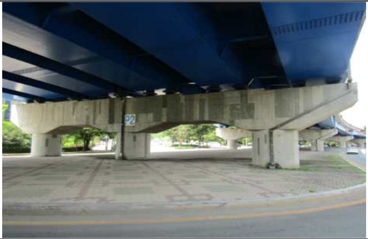
하부구조 전경 - 교각(P1)
