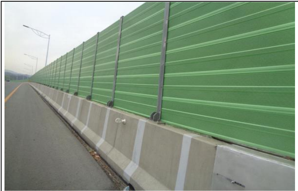
방호벽 및 방음벽 전경
