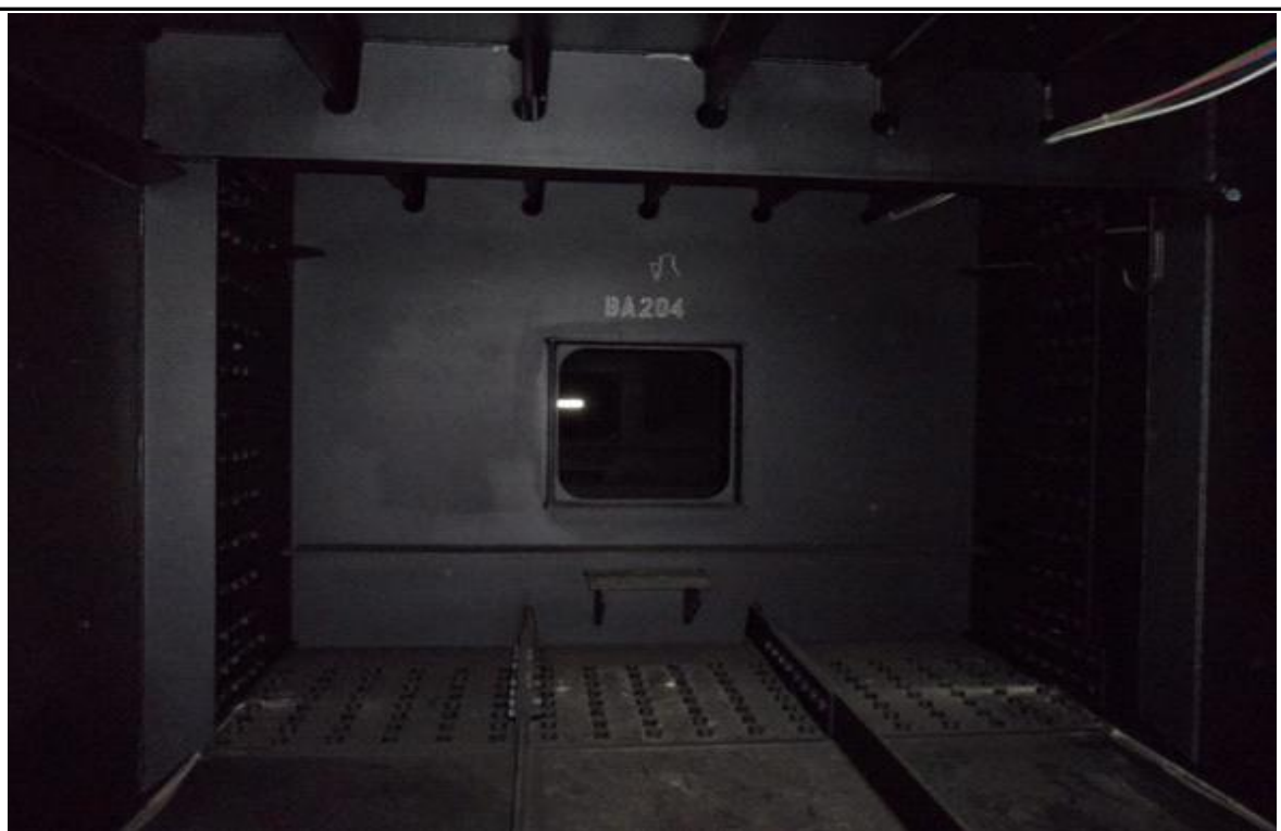
상부구조 전경 - 내부
